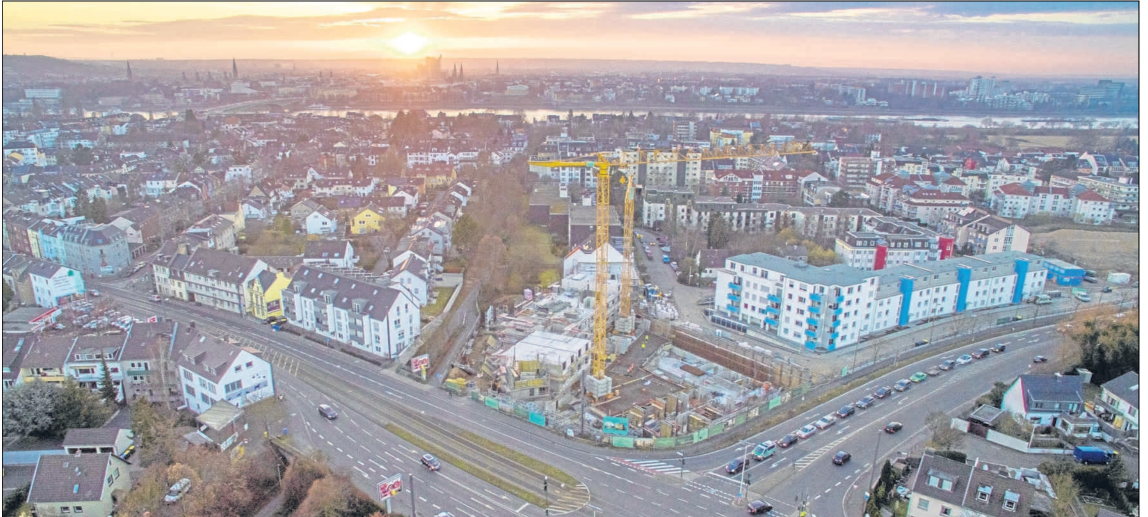
Auf rund 5000 Quadratmetern baut der Investor Bonava seit 2015. Das mittlere Areal mit 77 Mietwohnungen ist seit November fertig und bereits bezogen.
